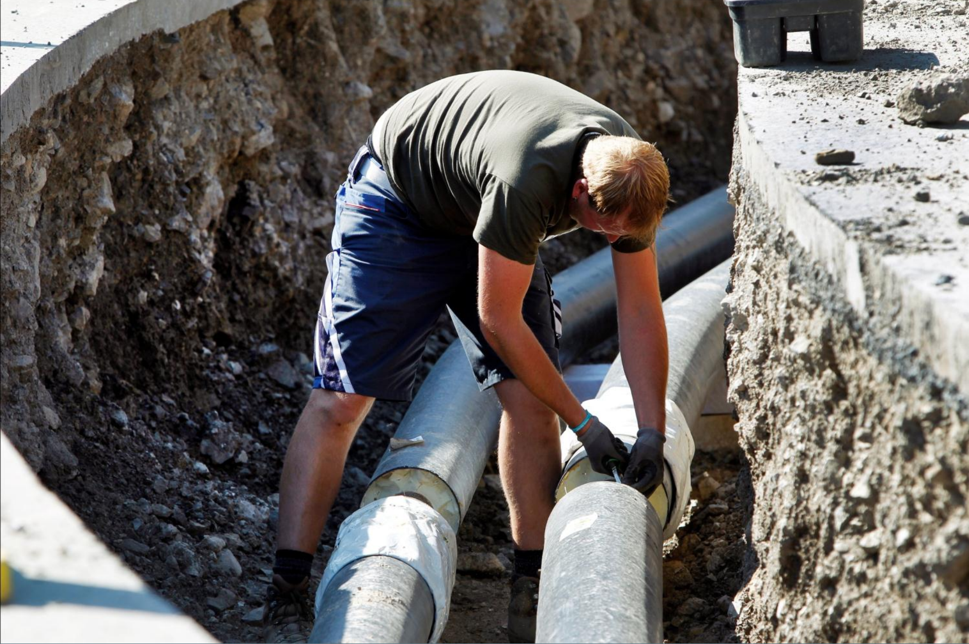
Isolationsarbeiten an den Schweisststellen
