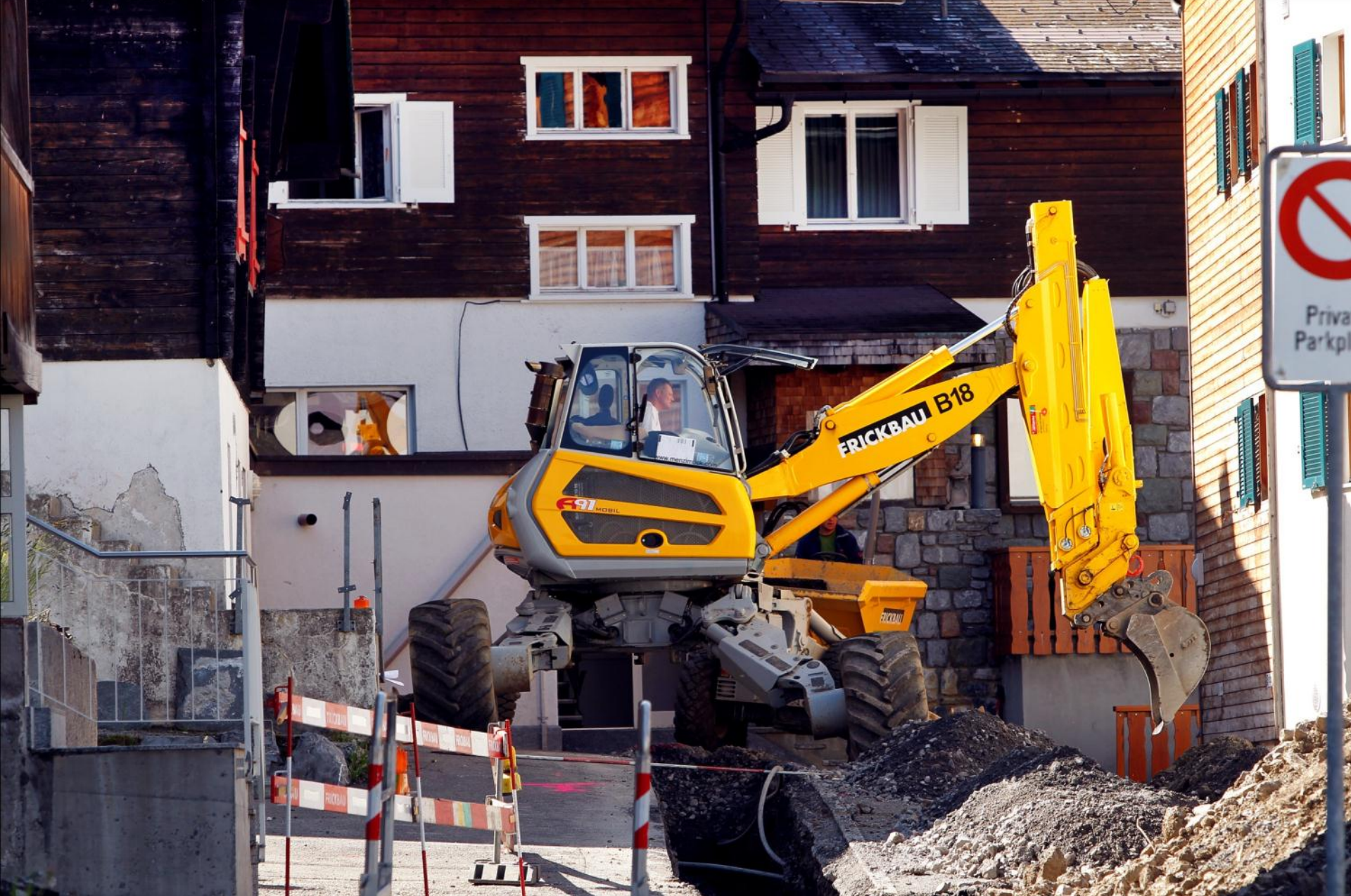
Grabarbeiten Restaurant Turna
