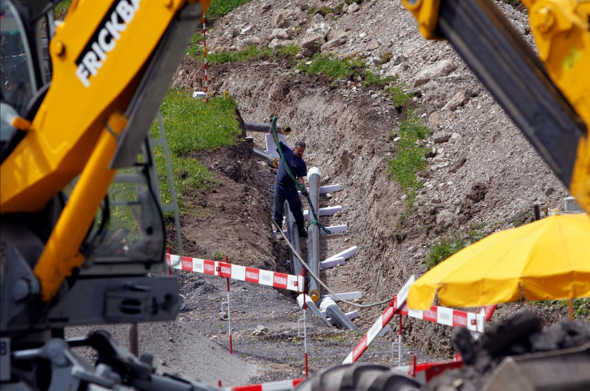
Arbeiten im Leitungsnetz
